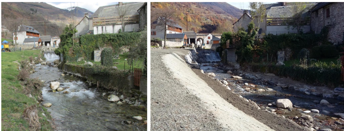
FIGURE 10 : PHOTOGRAPHIES DU RUISSEAU DU BARRICAVE À ILHET AVANT LES TRAVAUX, À GAUCHE, ET APRÈS LES TRAVAUX, À DROITE (SOURCE : CACG, 2019)
