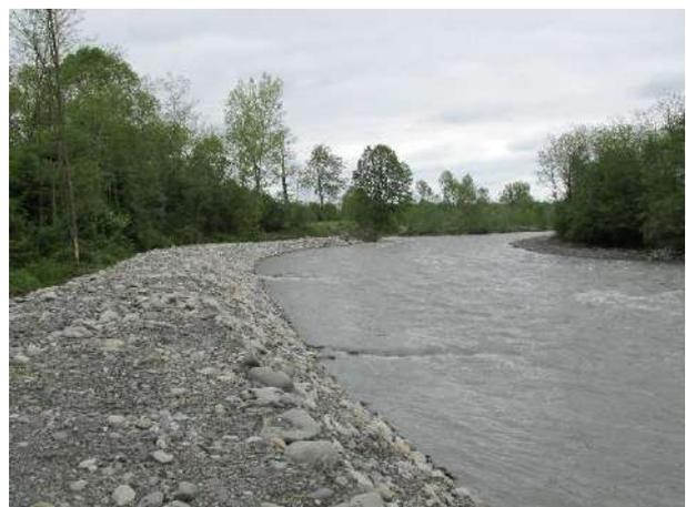
Digue de galets réalisée en post-crue 2013 - Bizous
