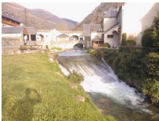
Vue du seuil depuis l'aval
